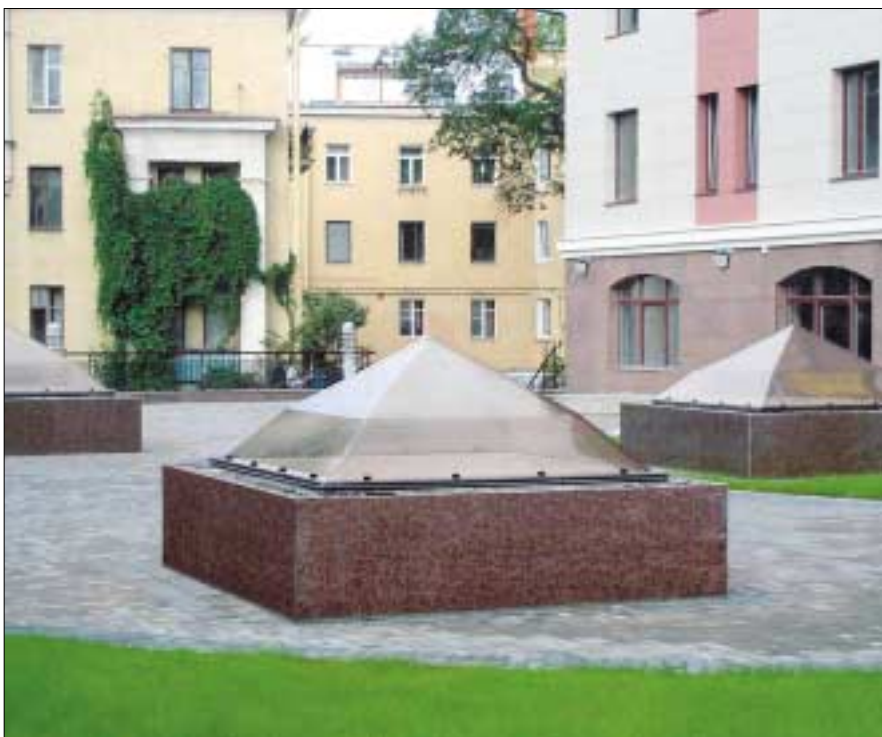
PM1N virsgaismas logi, dzīvojamās mājas pazemes garāžas jumts, Sanktpēterburga. Ūdeni aizturošās plāksnes ir aizvietotas ar granīta plāksnēm.
