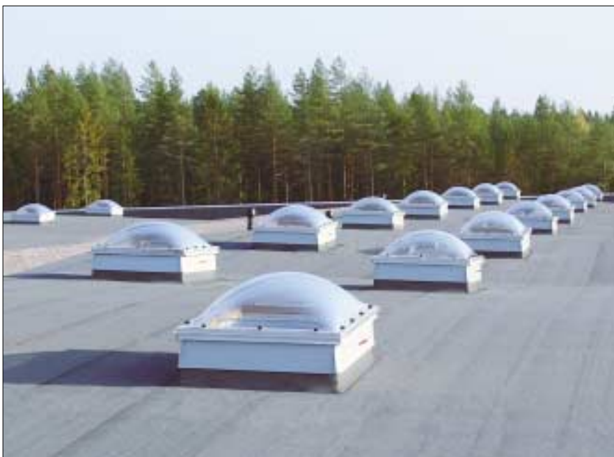
M3N virsgaismas logi, Hansa Logistics, Hamēnlinna. Virsgaismas logi papildus veic arī dūmu izvadīšanas lūkas funkciju.
